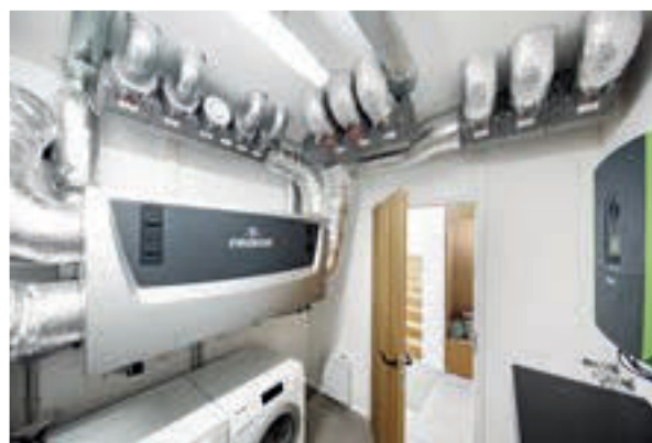
Die Frischluft-Wärmetechnik-Heizung macht eine extra Lüftung und die Fußbodenheizung überflüssig.
