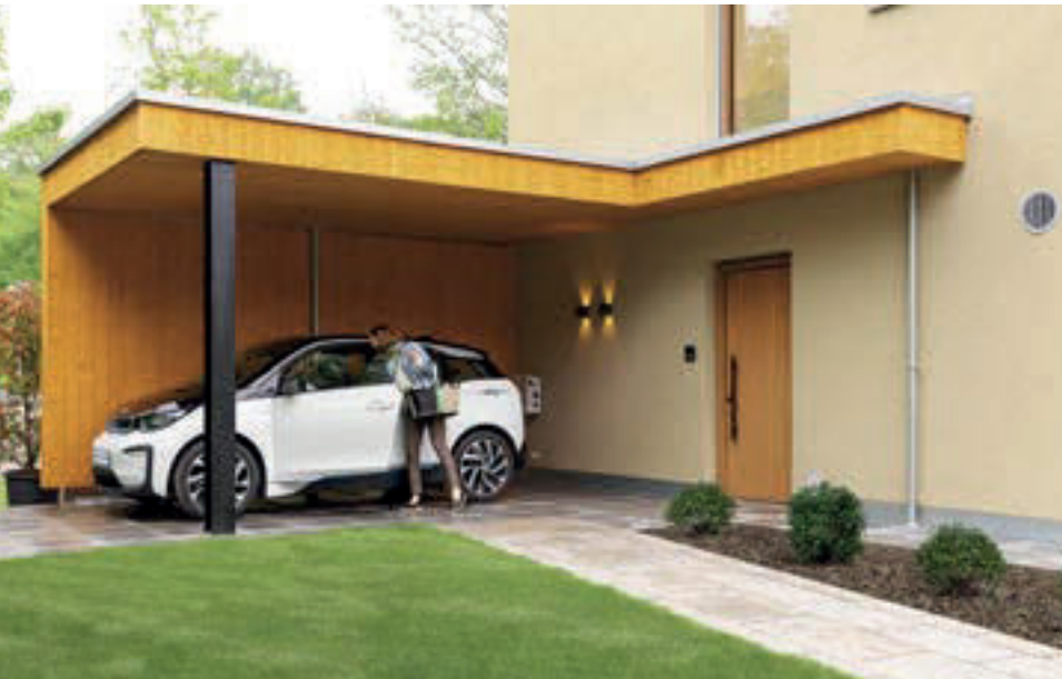
Der Carport als Hausvordach und Tankstelle: Die Ladestation sehen Sie hinten in der Ecke.
